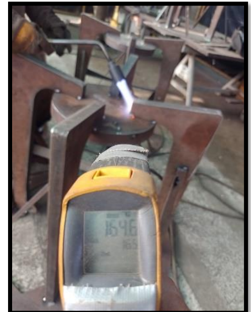
Fig.1: Precalentamiento del material
